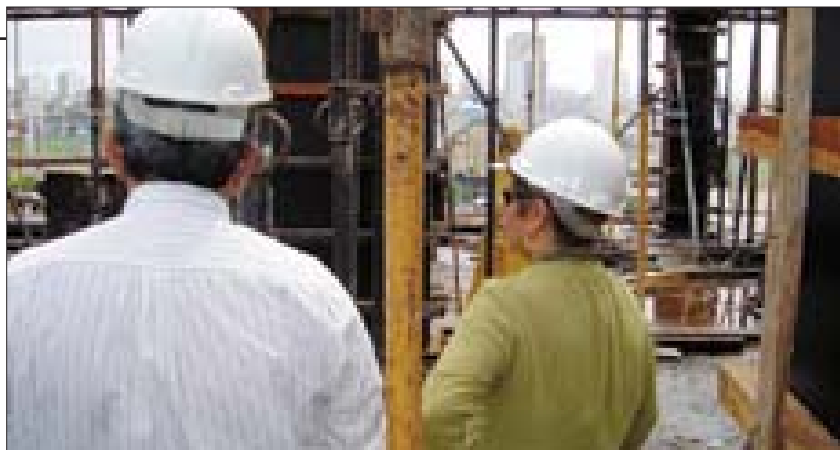
Desembargadora Maria de Lourdes visita obras da segunda torre do complexo da Justiça do Trabalho em Natal, onde vão funcionar mais setores do TRT da 21ª Região.
